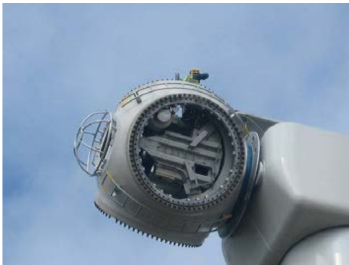
Rotorblattlager einer Windenergieanlage ohne montierte Rotorblätter (Quelle: Wikipedia – Paul Anderson / Hub secured to Turbine Tower No 11)
