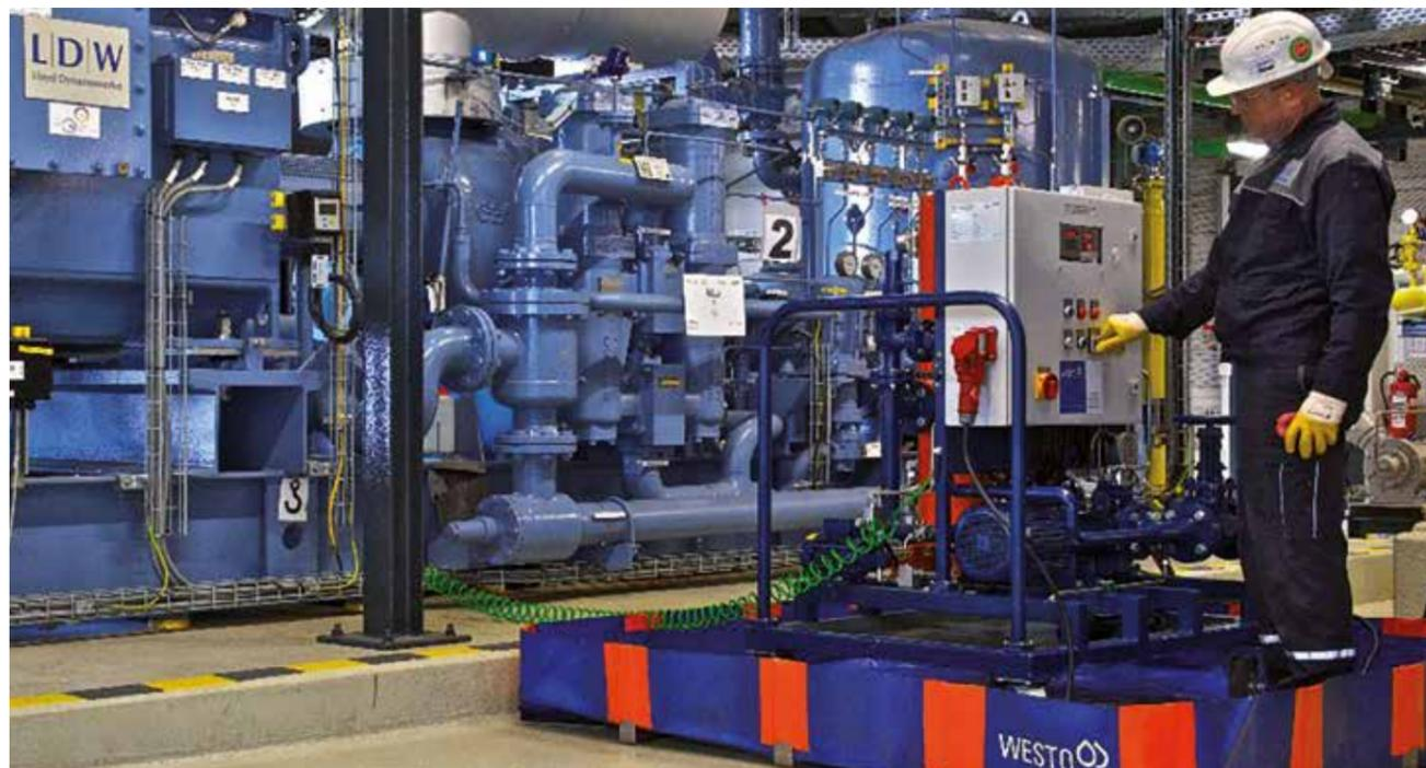
Von WESTO und Currenta gemeinsam entwickelt: ein speziell für die Schraubenverdichter der Kälteerzeugung konzipiertes Nebenstromfilteraggregat, das den Ammoniak-Anteil (NH<sub>3</sub>) im Ölkreislauf berücksichtigt.
