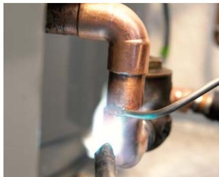
Flussmittel werden meist in Form von Lötwater beim Lötten von Kühlern und Leitungen eingesetzt, um eine bessere Benetzung der Oberflächen durch das Lot zu erreichen. Durch eine chemische Reaktion entfernen sie Oxidschichten und reduzieren die Oberflächenspannung. Ein besseres Lötgergebnis wird dadurch erreicht. Die meist säurehaltigen Flussmittel reagieren aggressiv und können, wenn
