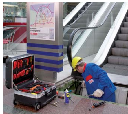
Wartung an einer Fahrtreppe
