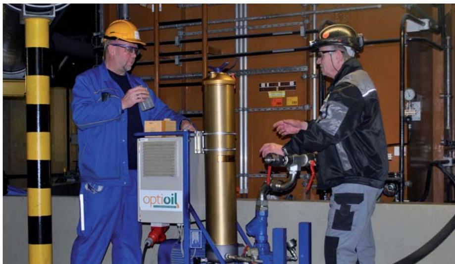
Nebenstrom-Filtration in einem Vattenfall Kraftwerk – Instandhalter und Optioil Experte bei der Entnahme einer Ölprobe.
