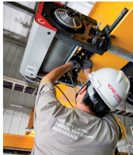
Arbeiten über Kopf – die Getriebe der Brückenkranen sind oben platziert. Dank der praktischen OELCHECK Probenpumpe gelingt die Entnahme der Ölproben ohne großen Aufwand.
